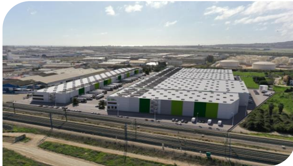
Málaga Green Logistics Park. Málaga, España.
